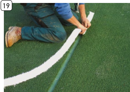
Vložení lajny do lepidla
