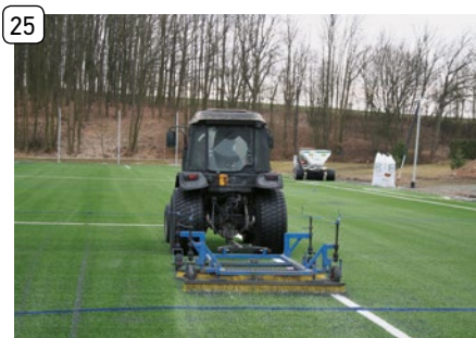
Kartáčování po zapravení zásypu - granulát
