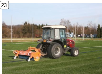
Kartáčování po zapravení zásypu - písek
