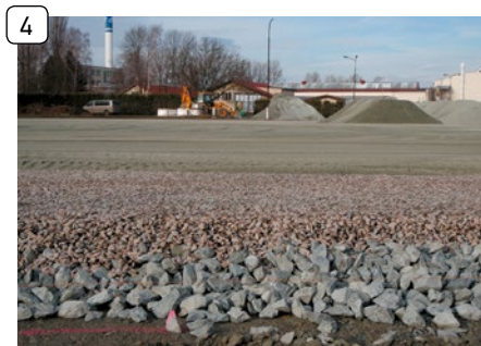
4 Vrstvy podkladní konstrukce
