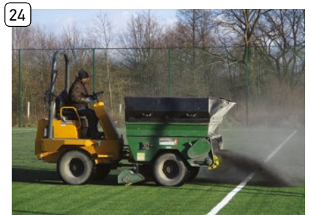
Vpravení zásypu do UT - granulát
