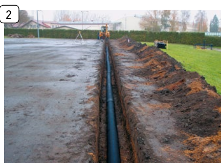
2 Výkop drenážního systému
