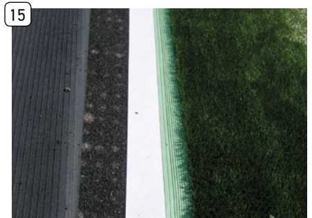
Vycentrování pásky s lepidlem a přiklopení UT na lepidlo
