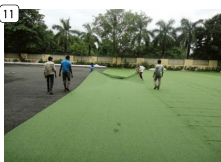
11 Umístění a napnutí pásů UT
