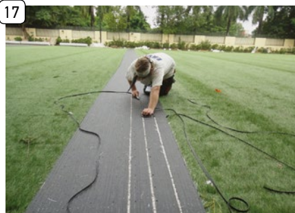
Rozřezání lajn, odříznutí části mezi stehy
