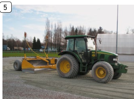
5 Rovnění vrstev laserovým grejdrem
