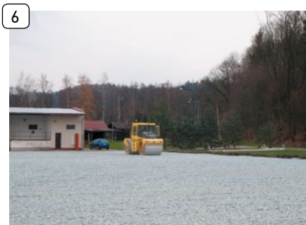
6 Hutnění konstrukčních vrstev
